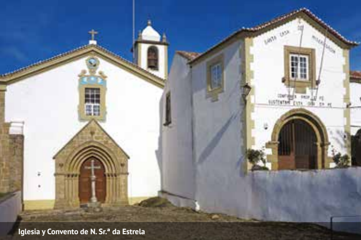
Iglesia y Convento de N. Sr.ª da Estrela
