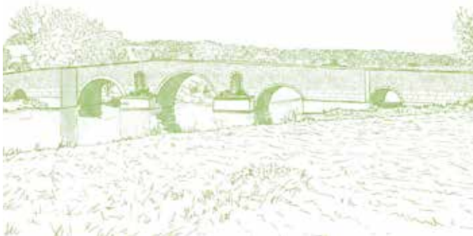
Römische Brücke über die Ribeira Grande. Derzeit mit 6 Bögen, möglicherweise aber sind weitere 6 Bögen unter der Erde versackt, infolge des Versandung des Flusses.
