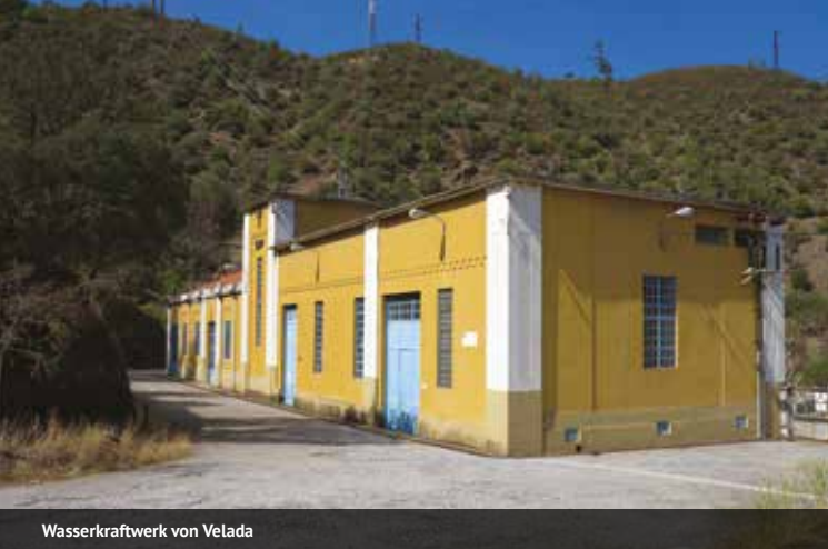
Wasserkraftwerk von Velada
