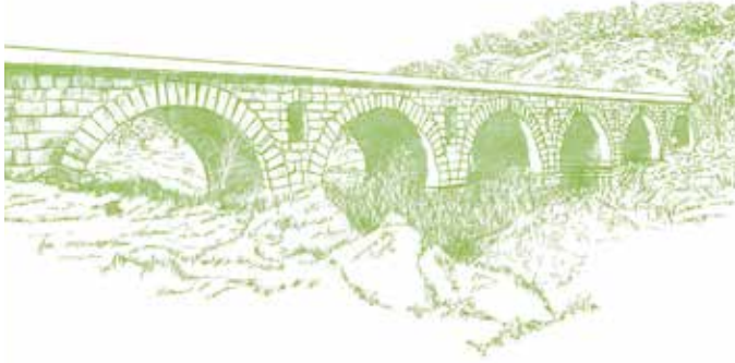
Römische Brücke von Vila Formosa - Nationaldenkmal. Wurde Ende des 1. / Beginn des 2. Jh. n.Chr. erbaut. Gehörte zu der Straße, die Olisipo (Lissabon) mit Emerita (Mérida) verband.
